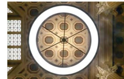
審査講評: 金融街のシンボリック的存在であった銀行の古典的大空間の保存・再生にあたって、照明計画が重要な鍵の一つとなった。従来の白熱灯によるスポット照明の代わりに、大空間に対してのミニマルなリングの中に LED を組込む方式をとって照度向上をはかるとともに、天井へのアップライト機能や机上照度向上のための自動調光システムの導入や地震時の振幅低減対策にも配慮して、古典空間に負けない見事なインテリアプロダクトが生まれた。
